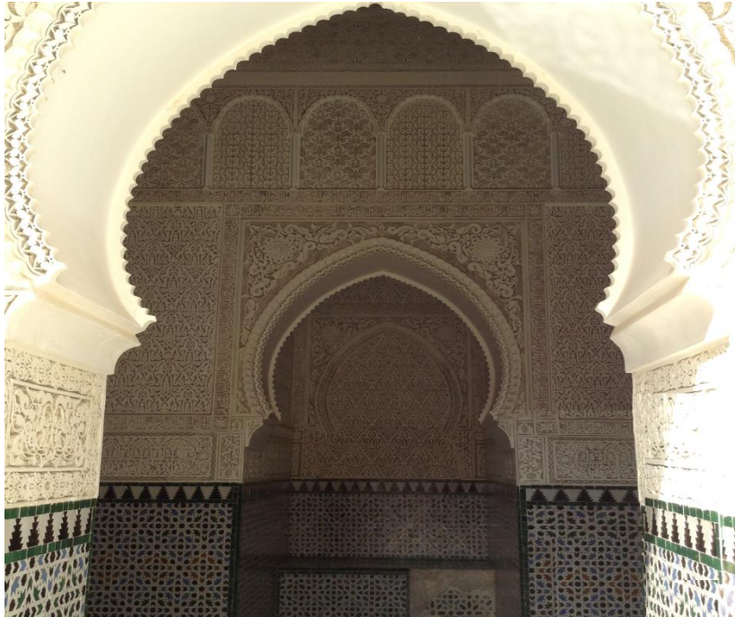
( الصورة رقم 26: صورة لمدخل وإيوان القاعة رقم 07 )
